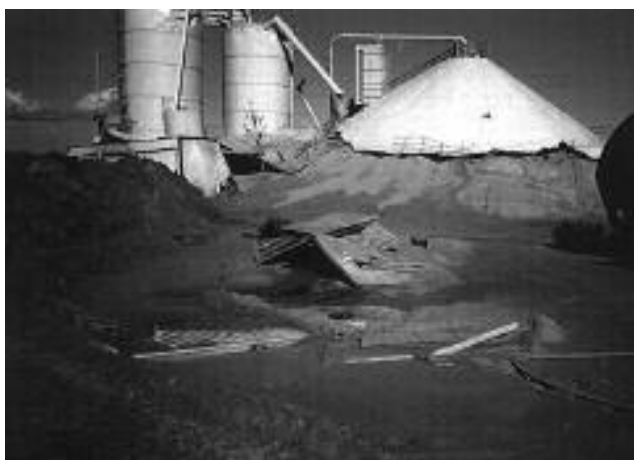
Silos zniszczony na skutek cyklicznych zmian temperatury [4] Silos failure as a result of cyclic temperature changes [4]
