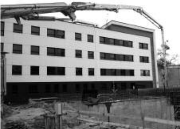
Fot. 3. Widok pompy podającej mieszankę betonową o gęstości min. 3200 kg/m 3 do szalunków bunkra akceleratorów wysokoenergetycznych w Ośrodku Radioterapii w Warszawie [Fot. Grzegorz Nowowiejski] Photo 3. Pumping of concrete mixture > 3200 kg/m 3 into formwork of particle accelerator building in Warsaw
