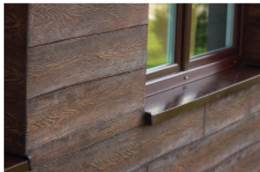
Fot. 4. Efekt deski uzyskuje się przez odciskanie silikonowych form w świeżym tynku ATLAS CERMIT WN
