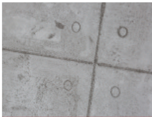
Fot. 3. ATLAS CERMIT BA-M odwzorowujący powierzchnię betonową
