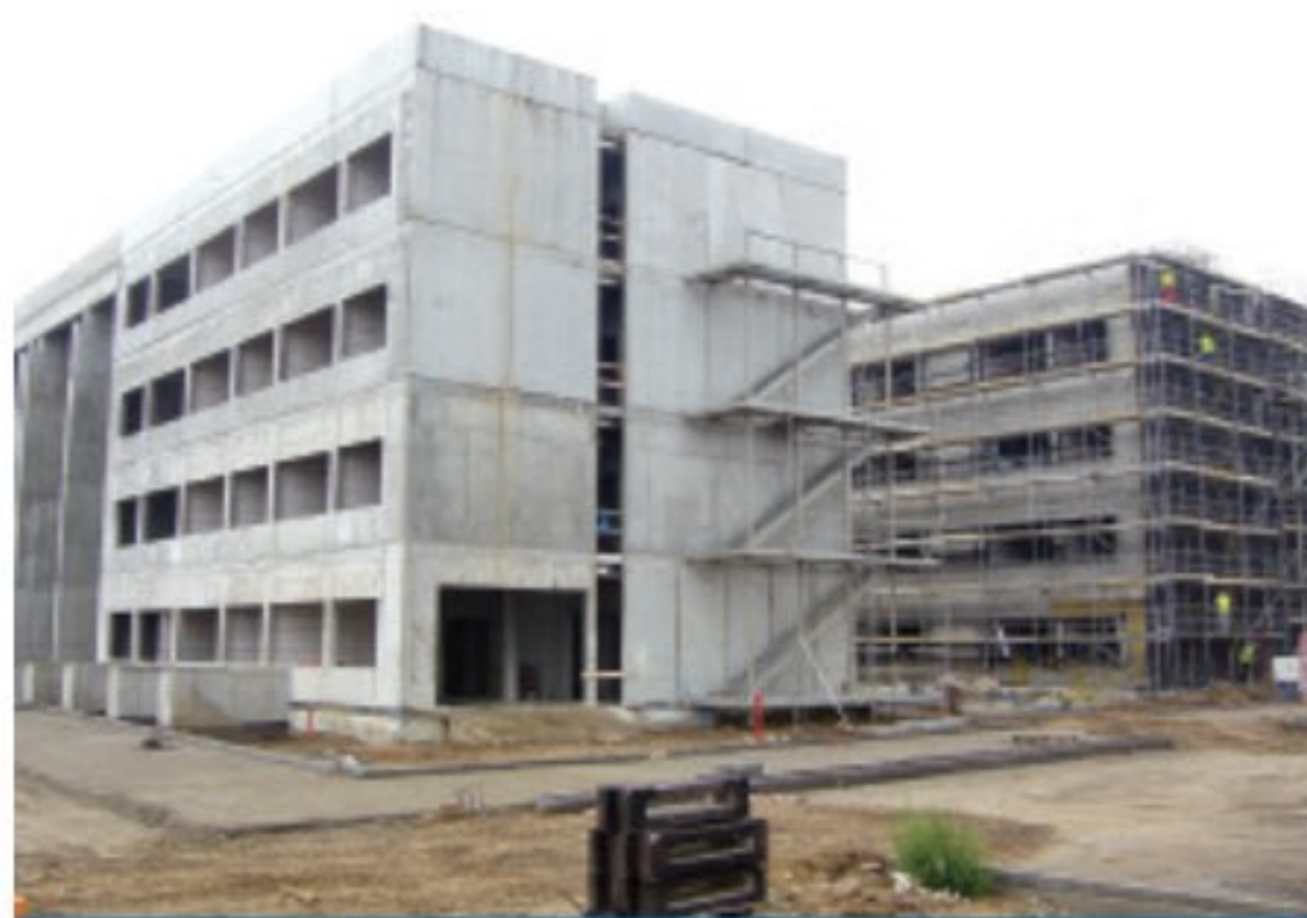
Budynki realizowane w technologii ścian zespolonych LEIER
