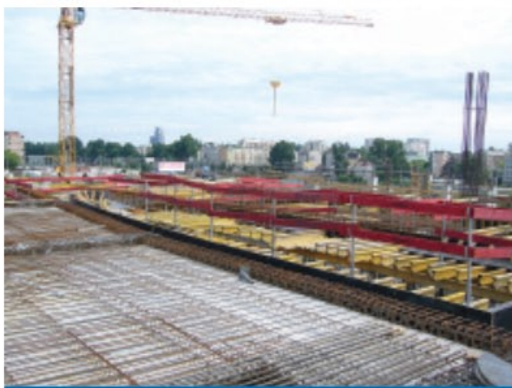
Strop LEIER-PANEL przed betonowaniem
