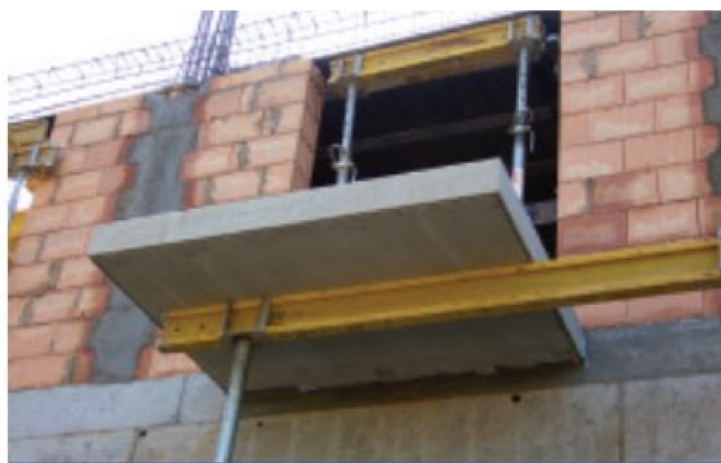
Balkony prefabrykowane typu LEIER-PANEL (z burty-krawędzią) w trakcie montażu
