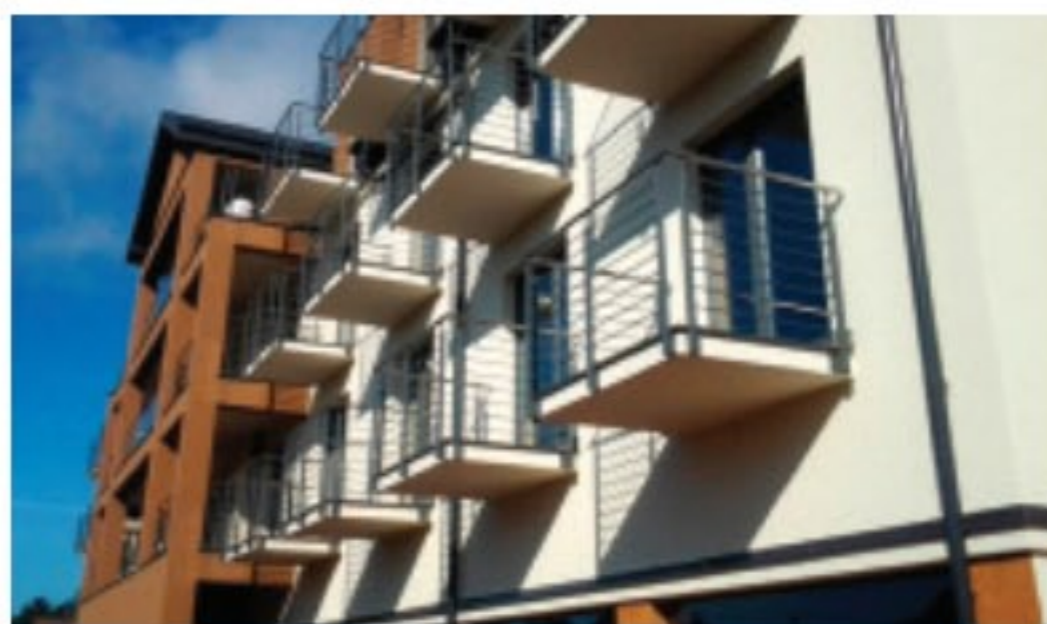
Balkony prefabrykowane typu LEIER-PANEL (z burty-krawędzią) w stanie wykończonym
