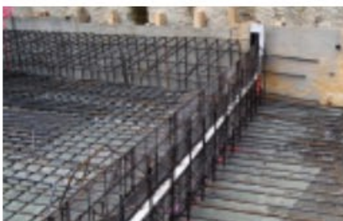
Przykład zastosowania szalunku traconego Stremaform® z blachą uszczelniającą w płycie fundamentowej
