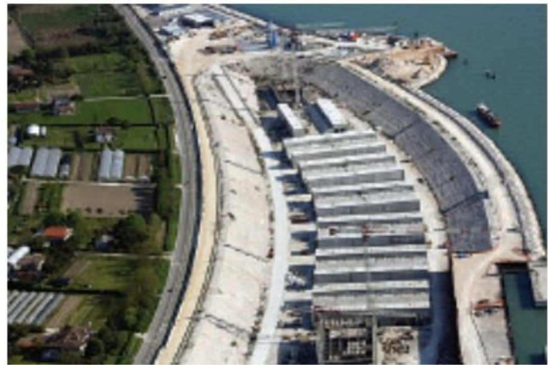
Budowa Nabrzeża w Wenecji
