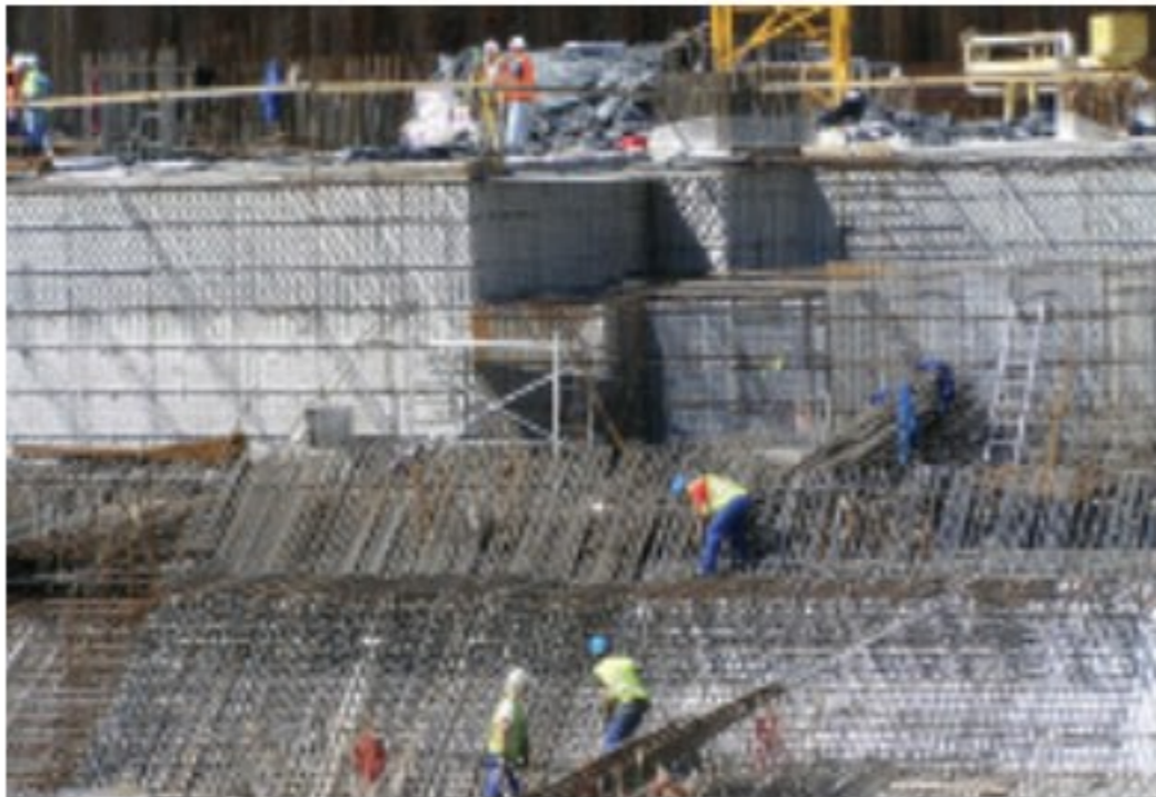
Płyta fundamentowa wieżowca SkyTower we Wrocławiu
