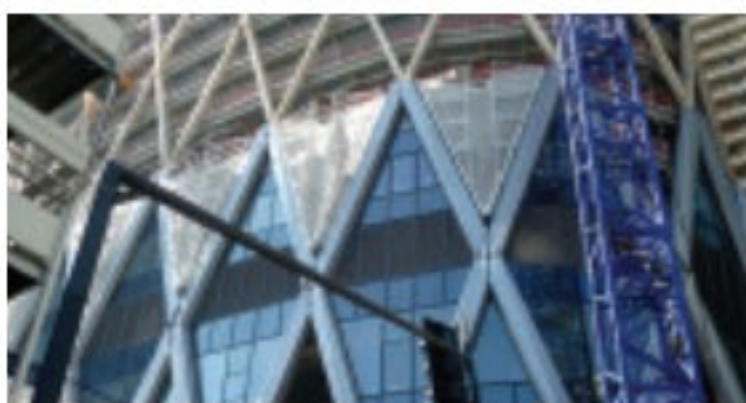
Fot. 6. Wieżowiec D2 Tower w Paryżu – widok na fragment elewacji
