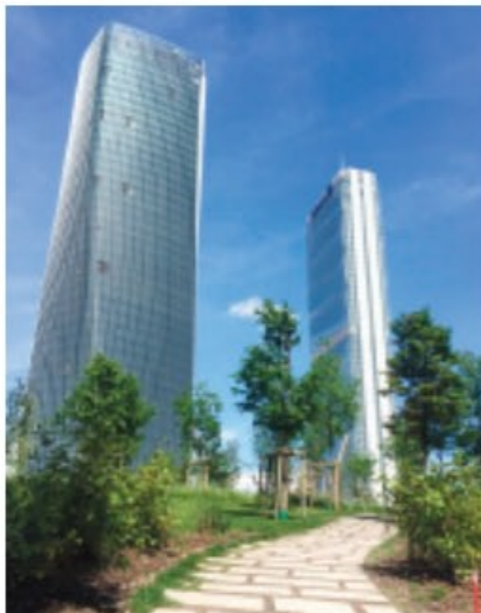
Fot. 4. Wieżowiec Allianz Tower w Mediolanie (z prawej) – widok na kompleks wieżowców w dzielnicy CityLife [©CityLife] Photo 4. Skyscraper the Allianz Tower in Milan (right) – view of a complex of skyscrapers in the CityLife
