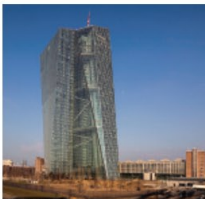
Fot. 1. Siedziba Europejskiego Banku Centralnego ECB we Frankfurcie nad Menem – widok na dwie wieże połączone atrium
