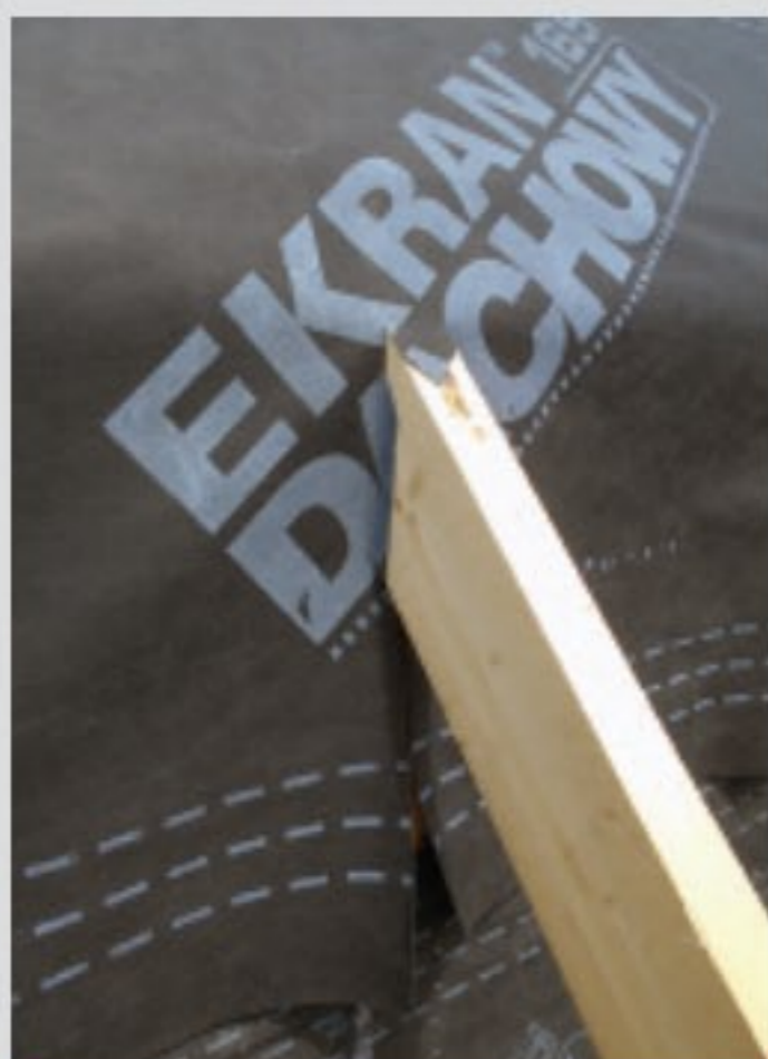
Fot. 7. Uzyskanie szczelności powietrznej wokół krokwi i murlaty wymaga specjalnego ułożenia warstw uszczelniających. Na tym dachu płyty PIR zostały ułożone w systemie mieszanym: międzykrokwiowo (8 cm) i nakrokwiowo (8 cm). Widoczna MWK jest warstwą uszczelniającą powietrznie
