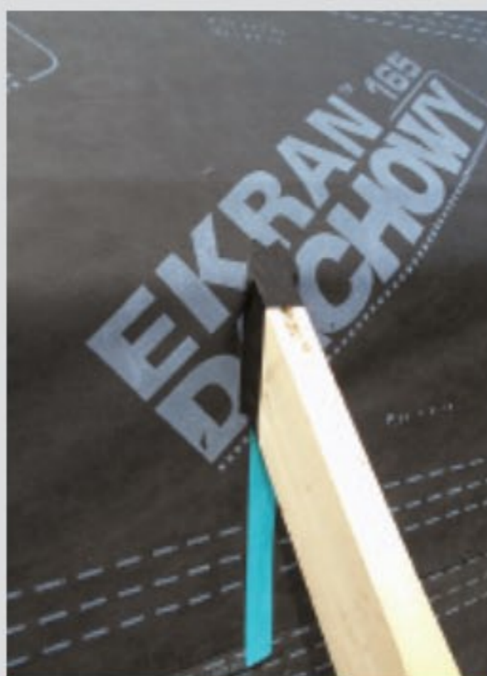
Fot. 9. Dach z fotografii 7 i 8. Widać jak, po odpowiednim nacięciu, trzeba oklejać krokwie, aby uzyskać szczelność powietrzną. MWK leżąca między warstwami PIR była przyklejona również do ścian zarówno pod okapami, jak i w szczytach budynku
