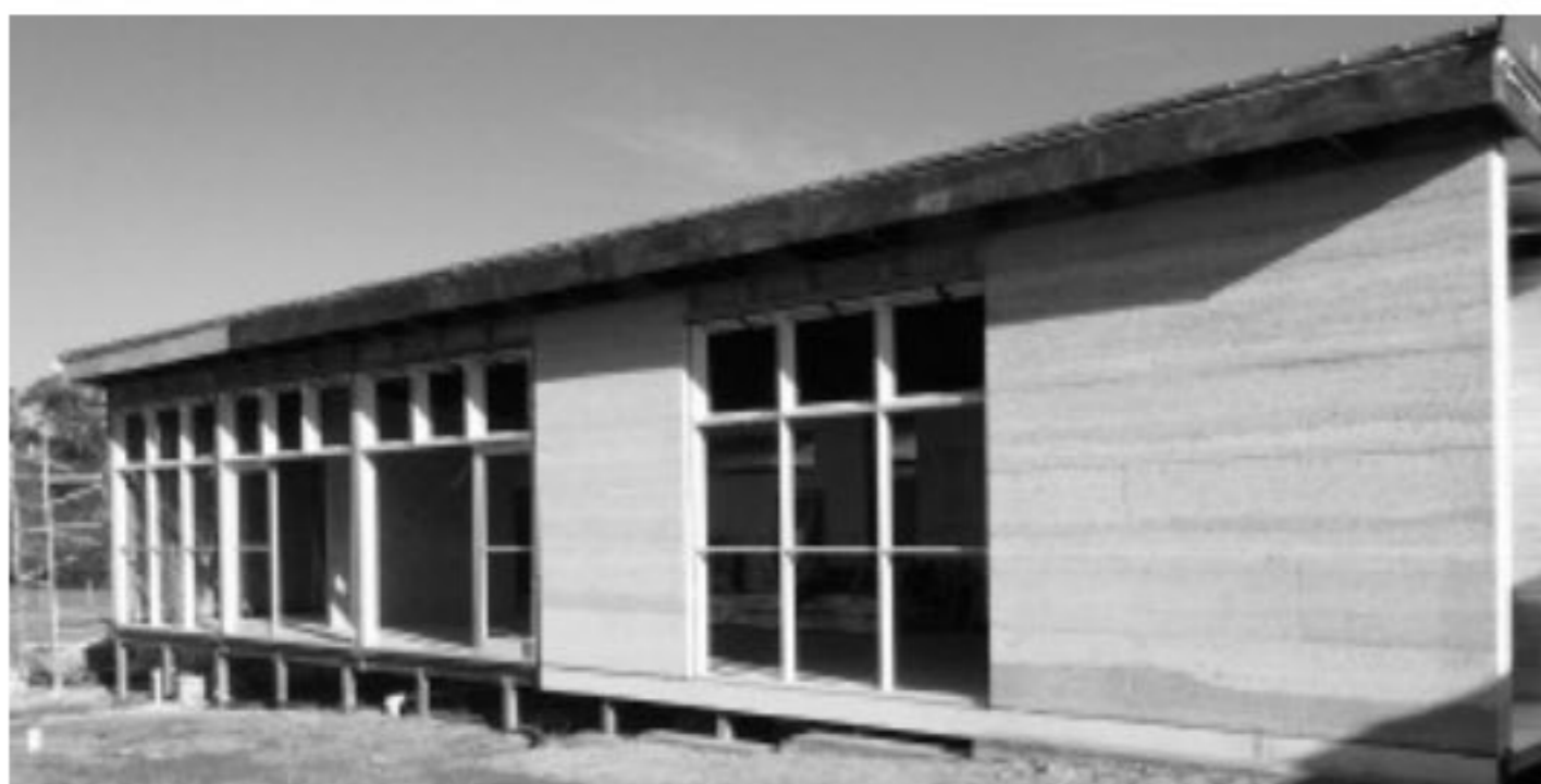
Przykład budowy obiektu w technologii hempcrete
