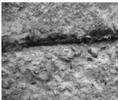
Photo 5. Detail of reinforcement corrosion Fot. 5. Szczegóły korozji zbrojenia
