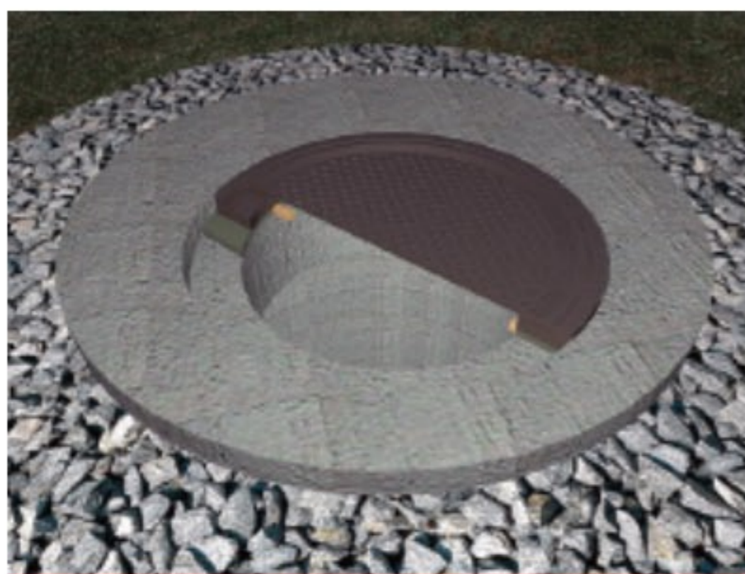
Rys. 2. Właz studzienki kanalizacyjnej zamontowany za pomocą zaprawy ATLAS MONTER T-15
