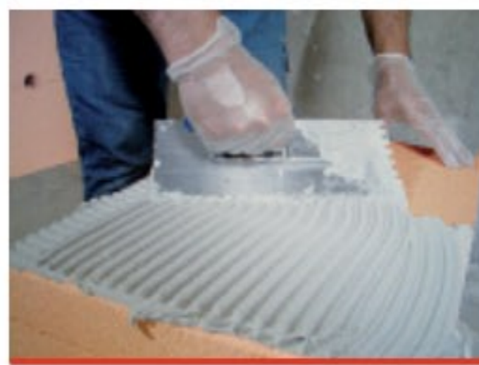
Fot. 5. Nakładanie kleju KEIM Mycal-Por
