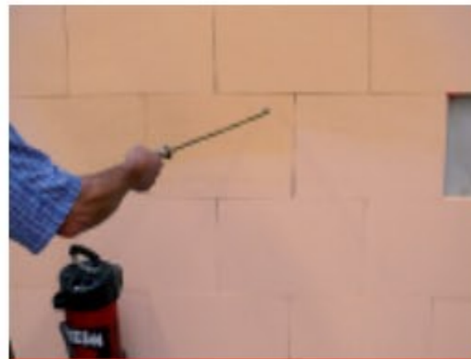
Fot. 6. Gruntowanie przyklejonych płyt
