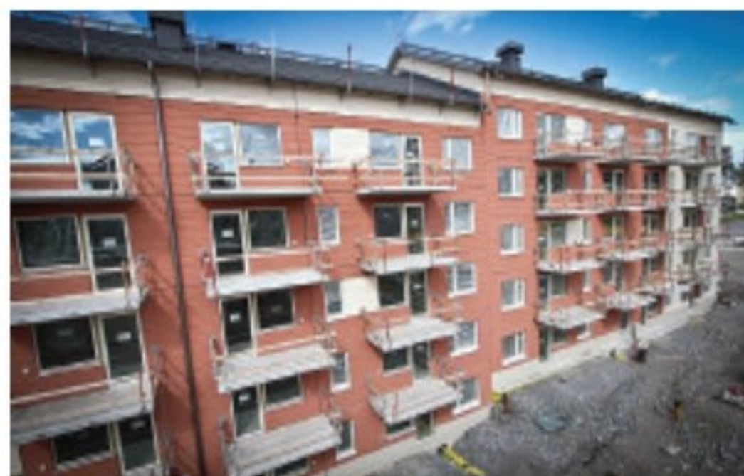
Fot. 1. Budynki mieszkalne w Skandynawii zrealizowane z prefabrykatów betonowych produkowanych przez „Pekabex”
