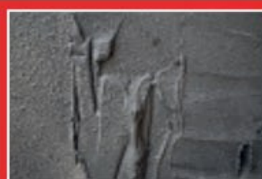
Tak nie należy nakładać powłoki hydroizolacyjnej, ale warto zauważyć, że nie powstały żadne rysy
