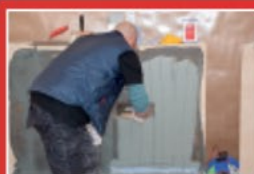
Pokaz optymalnego sposobu nakładania MB 2K z użyciem pacy dystansowej
