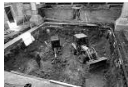
Fot. 1. Pogłębienie podscenia – wykonana palisada i częściowo oczep palisady Photo 1. Trap room digging – completed jet-grouting palisade
