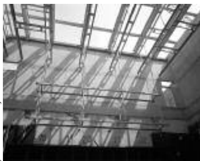
Fot. 2. Nadbudowa wieży scenicznej – widoczna konstrukcja stropodachu oraz blokowni i pomostów oświetleniowych Photo 2. Top of stage tower – roof and grid construction
