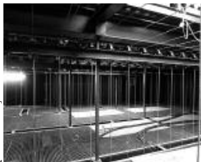
Fot. 3. Widok gotowej blokowni podwieszanej do stropodachu Photo 3. Completed grid suspended to roof construction
