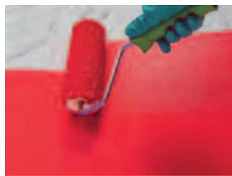
Fot. 2. Nanoszenie powłoki ochronnej w systemie MC-Color Flex
