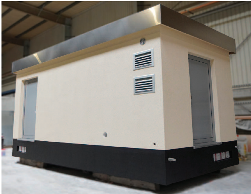
Fot. 4. Gotowy prefabrykowany kontener żelbetowy. Atyka dachu została zabezpieczona elementami ze stali nierdzewnej
