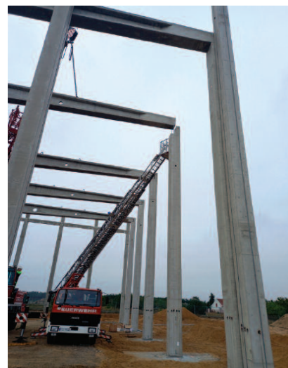
Montaż dźwigara na słupie
