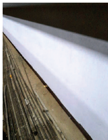
Fot. 5. Belka T o prawidłowej strukturze powierzchni
