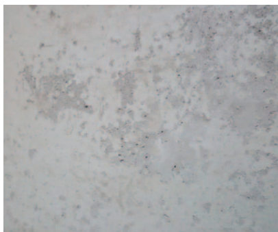
Fot. 3. Skutek niedokładnego doczyszczenia formy
