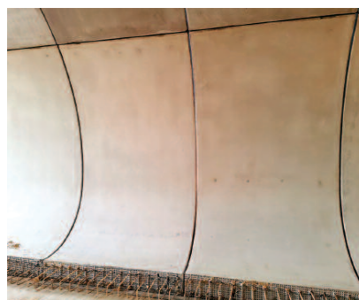
Fot. 4. Rozmieszczenie dystansów betonowych i ich widoczność na ekspozowanej powierzchni prefabrykatu betonowego
