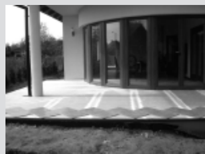
Przykład ułożenia maty uszczelniającej na tarasie
