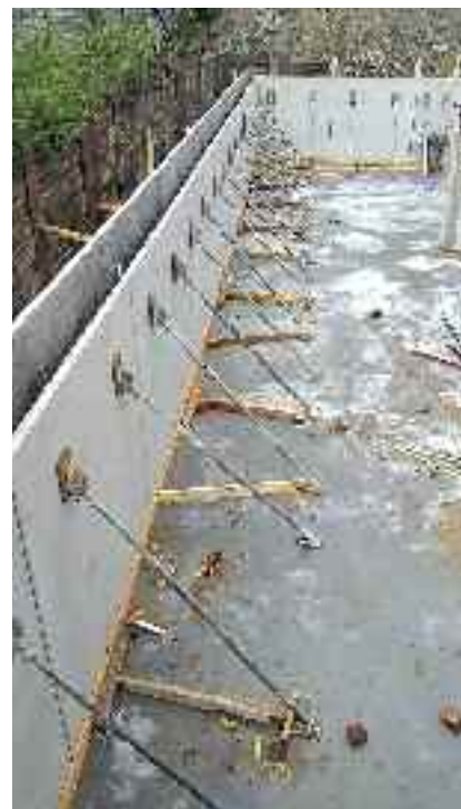
Fot. 2. Montaż podwójnej ściany FILIGRAN
