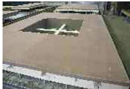
Fot. 1. Produkcja podwójnej ściany z wewnętrzną warstwą izolacji
