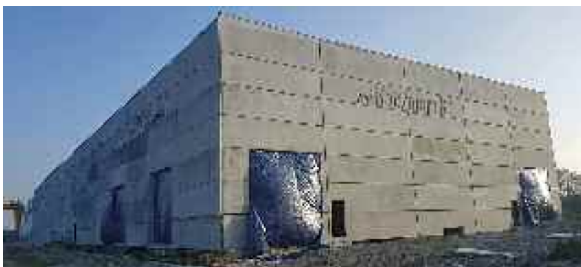
Fot. 4. Hala z prefabrykatów typu SANDWICH
