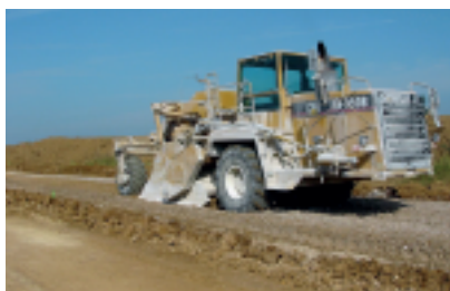
Fot. 1. Recykler do stabilizacji gruntu
