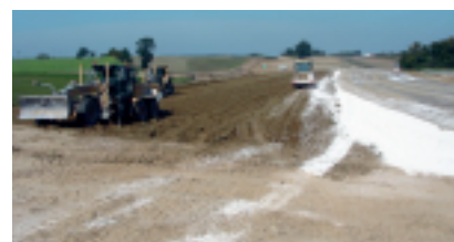
Fot. 3. Grunt przed i po stabilizacji wapnem
