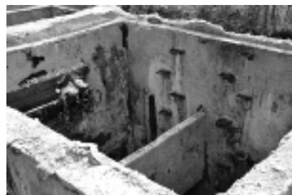
Fot. 1. Widok odkrytej komory rozprężnej
