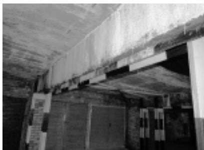
Fot. 5. Podpory stalowe rygli żelbetowych
