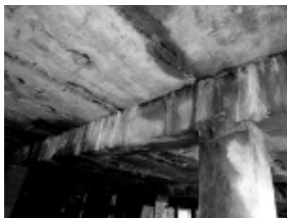
Fot. 1. Ogólny widok stropu nad parkingiem
