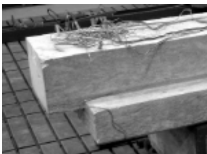
Fot. 1. Strefa przypodporowa belki wspornikowej
