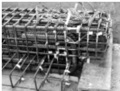
Fot. 2. Tensometry na zbrojeniu
