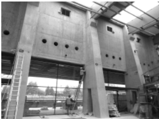
Fot. 2. Wejście do budynku – beton architektoniczny w kolorze naturalnym
