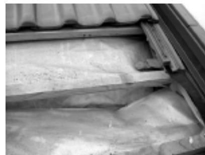
Fot. 2. Przewiewana połąć dachowa izolowana wełną mineralną
