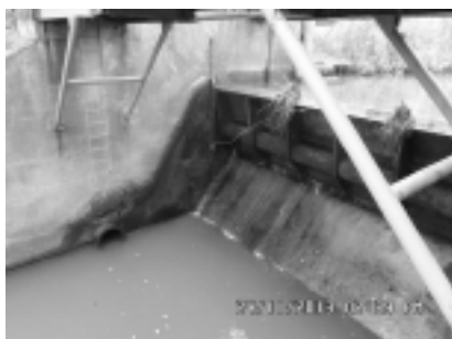
Fot. 2. Widok na klapę od strony WD
