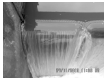
Fot. 1. Przepływ wody przez kłapę
