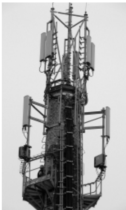
Fot. 1. Komin 1 o przekroju ośmiobocznym
