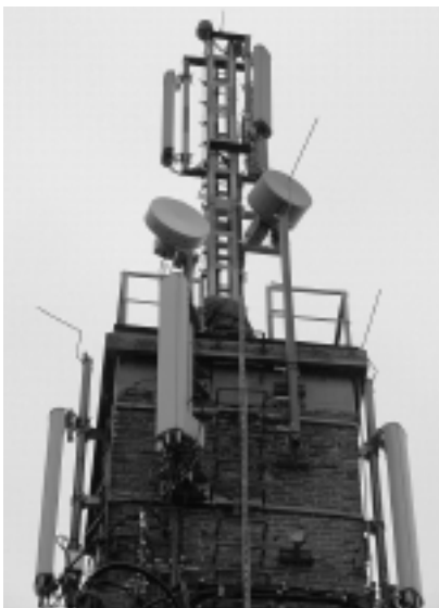
Fot. 3. Naprawa uszkodzenia komina 3 za pomocą mat z włókna węglowego
