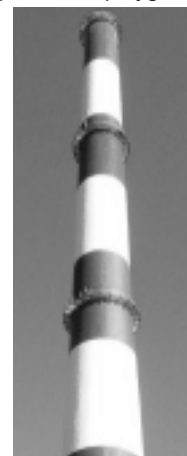
Fot. 3. Widok kominia po remoncie
