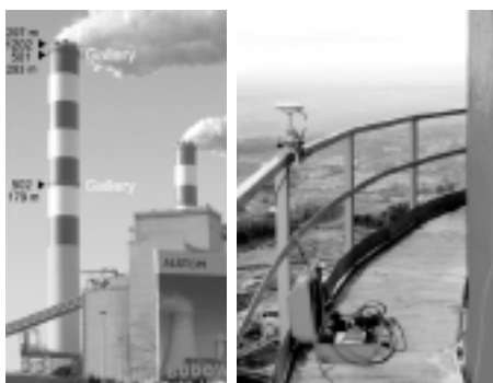
Lokalizacja 3 odbiorników GPS typu „rover” na kominie i sposób ich instalacji do barierki galerii zewnętrznych [Fot. P. Breuer]
