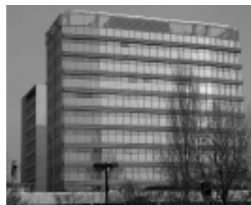
Fot. 3. Budynek po wykonaniu termomodernizacji
