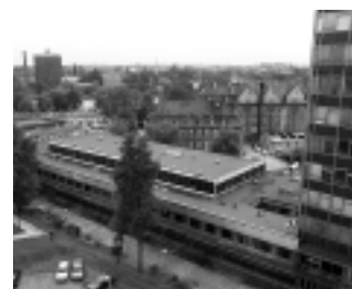
Fot. 2. Część niska budynku przed remontem
