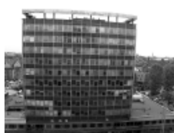
Fot. 1. Wysoka część budynku przed remontem
