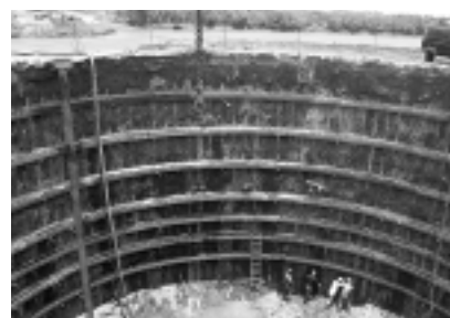
Fot. 4. Most Fatala. Obudowa masywnego fundamentu filara rzecznego formowana z kolumn iniekcyjnych wzmocniona mikropalami [1]
