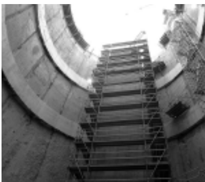
Fot. 2. Obudowa ze ścian szczelinowych szybu tunelu pod Wisłą [Fot. P. Rychlewski]
