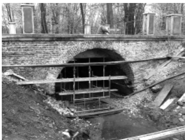
Most w czasie prac konserwatorsko-remontowych
