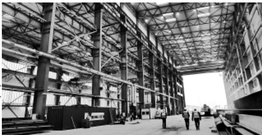
Wytwórnia konstrukcji stalowych Grupy Vistal zlokalizowana na Nabrzeżu Indyjskim
