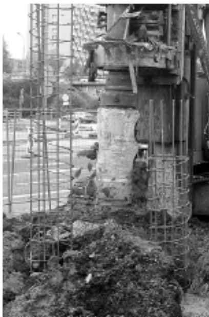
Montowanie zbrojenia pali CFA
