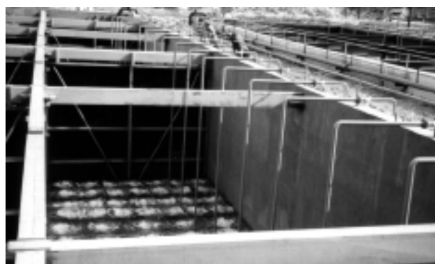
Widok ogólny komory napowietrzania ścieków w Bytowie – po naprawie
