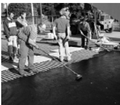
Fot. 2. Montaż instalacji ogrzewania w nawierzchni mostu w Berkenthin [1]
