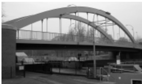
Fot. 1. Obiekt mostowy B 208 w miejscowości Berkenthin (M. Motylski)
