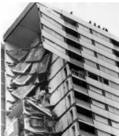
Zniszczenie 22-piętrowego wieżowca w Londynie w 1968 r. [Photograph Copyright Daily Telegraph, 1968]
