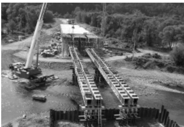
Budowa mostu na rzece Skawie
