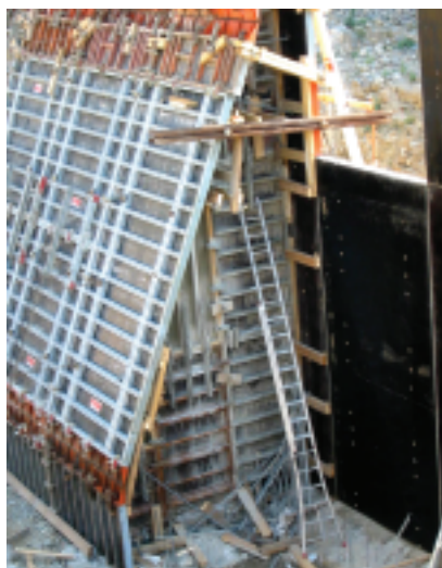
Zastosowanie szalunku NOEtop do wykonania przegrody pionowej o pochylej powierzchni
