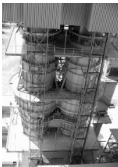
Piec Maerza do wypalania wapna (Fot. archiwum SPW)
