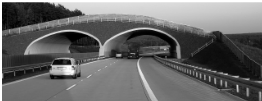
Autostrada A4 na odcinku Zgorzelec – Krzyżowa, na której zastosowano nawierzchnię betonową
