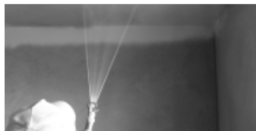
Nakładanie gładzi polimerowej agregatem hydrodynamicznym (Fot. Alpol Gips Sp. z o.o.)
