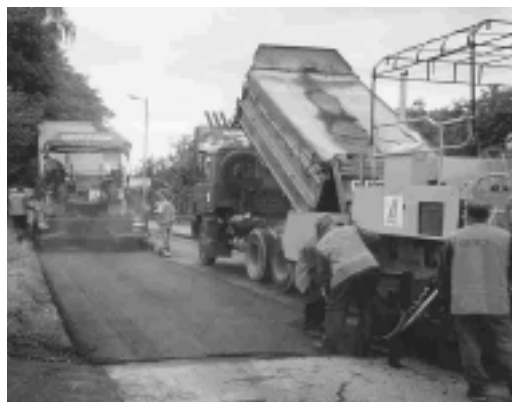
Fot. 2. Prace drogowe na odcinku doświadczalnym w Gdyni
