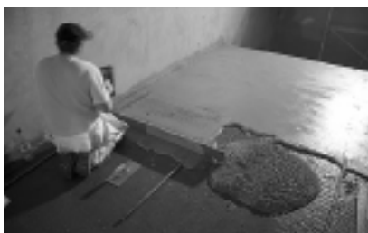
Remont zbiornika na wodę pitną w Niemczech w technologii MC-RIM PW
