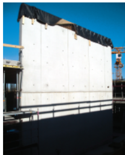
Ściana wykonana z zastosowaniem deskowań NOEtop
