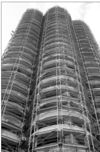
Konstrukcja rusztowania firmy ALTRAD-Mostostal przy wieżowcu mieszkaniowym na Osiedlu Tysiąclecia w Katowicach
