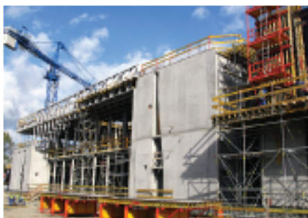
Przykłady zastosowanych systemów desekowań PERI na budowie Centrum Nauki Kopernik
