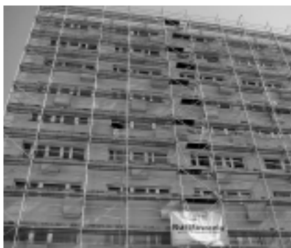
Fot. 3. Prawidłowe wykonanie stężeń rusztowania w układzie wieżowym (archiwum firmy PIONART)
