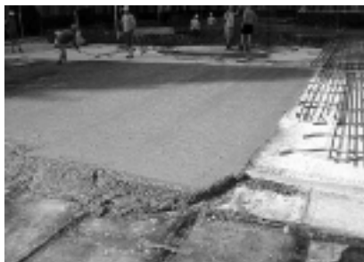
Fot. 7. Świeża lub gotowa warstwa wyrównawcza
