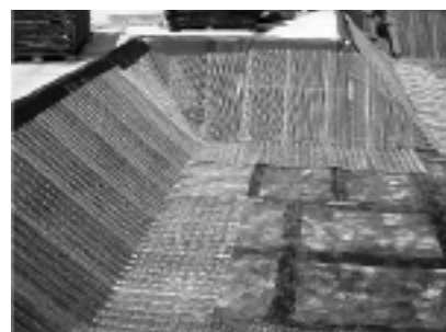
Fot. 11. Ułożenie siatki żebrowanej na powierzchni bocznej
