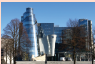
Nowa siedziba Telewizji Polskiej w Warszawie – izolacja płyty dennej i ścian fundamentowych w systemie PREPRUFE/BITUTHENE firmy GRACE (2001/2002)
