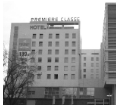
Fot. 2. Budynek Hotelu Premiere Classe przy ul. Towarowej w Warszawie
