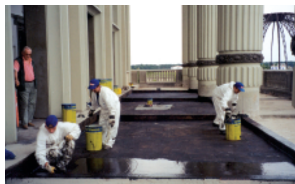
W Bazylice w Licheniu wykonano hydroizolację międzywarstwową w technologii Deitermann
