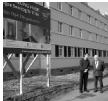
Fot. 2. Budynek mieszkalny w Dreźnie ocieplony od wewnątrz płytami CALSITHERM KLIMAPLATTE
