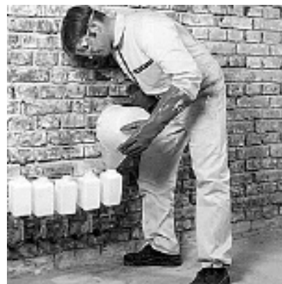
Wykonanie przepony przeciwwilgociowej metodą iniekcji bezciśnieniowej z zastosowaniem zasobników dozujących
