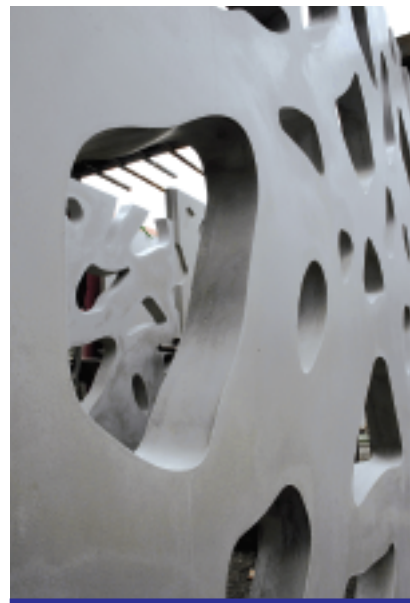
Ściana z betonu architektonicznego, wykonana w technologii SCC. Szalunki pokryto środkiem antyadhezyjnym CHRYSO®Dem Ekla 12
