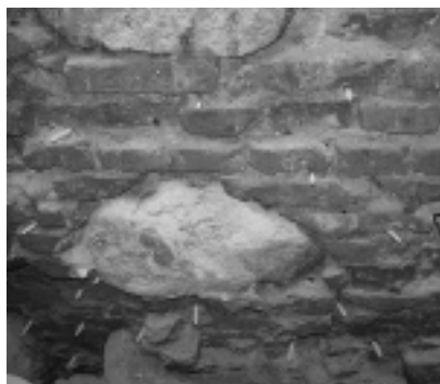
Fot. 3. Wnętrze bastionu – widok muru ściany wzmacnionej metodą iniekcji ciśnieniowej
