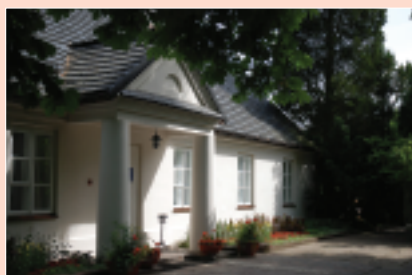
Dworek Chopina w Żelazowej Woli – izolacja wraz z osuszaniem metodą TERMOINIEKCJI (2006/2007)
