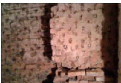
Hydrofobizacja powierzchni pionowej fragmentu muru w piwnicach Zamku Ostrogskich w Warszawie
