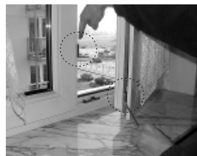
Fot. 12. Rozminięte zaczepy listwy okuciowej i zaczepy na słupku (Fot. Autor)
