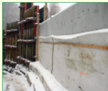
Izolacja pionowa ściany fundamentowej z maty wykonywana zimą
