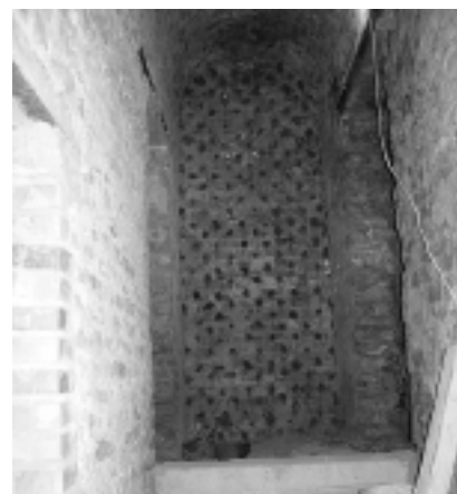
Fot. 4. Wnętrze bastionu – widok muru ściany zachodniej, zabezpieczonej metodą termoiniekcji, przewidzianej do tynkowania
