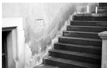
Fot. 3. Piwnica Świdnicka. Widok wysolenia na powierzchni zewnętrznej ściany południowej Ratusza
