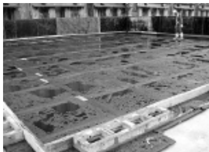
Fot. 6. Ułożona mata wibroizolacyjna Cimax. Szalunek na warstwę wyrównawczą
