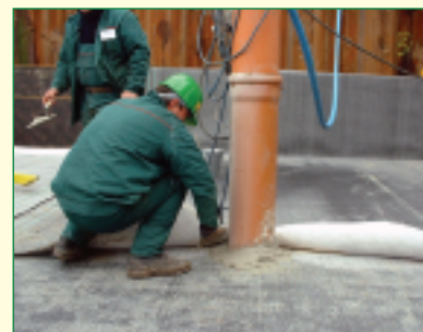
Uszczelnianie przejścia instalacyjnego szpachlą bentonitową
