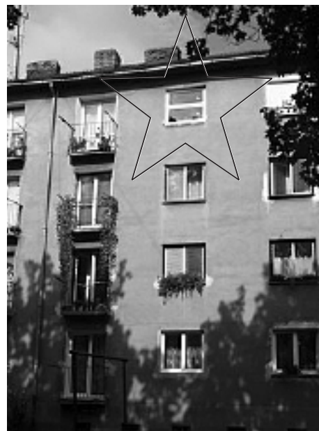
Fot. 22. „Leżące” okno widoczne w elewacji (Fot. Jarosław Cichawa)
