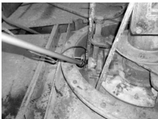
Fot. 6. Pomiar ciśnienia przy uchylonej osłonie otworu rewizyjnego dyszy zasypowej
