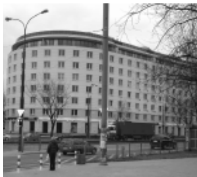
Fot. 1. Budynek WAN
